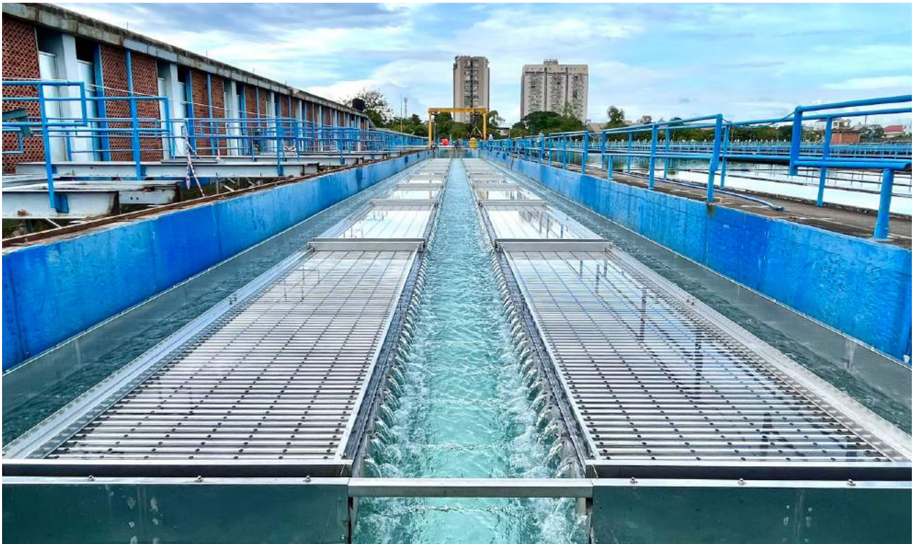
Hình ảnh: Nhà máy nước - B.O.O Thủ Đức
